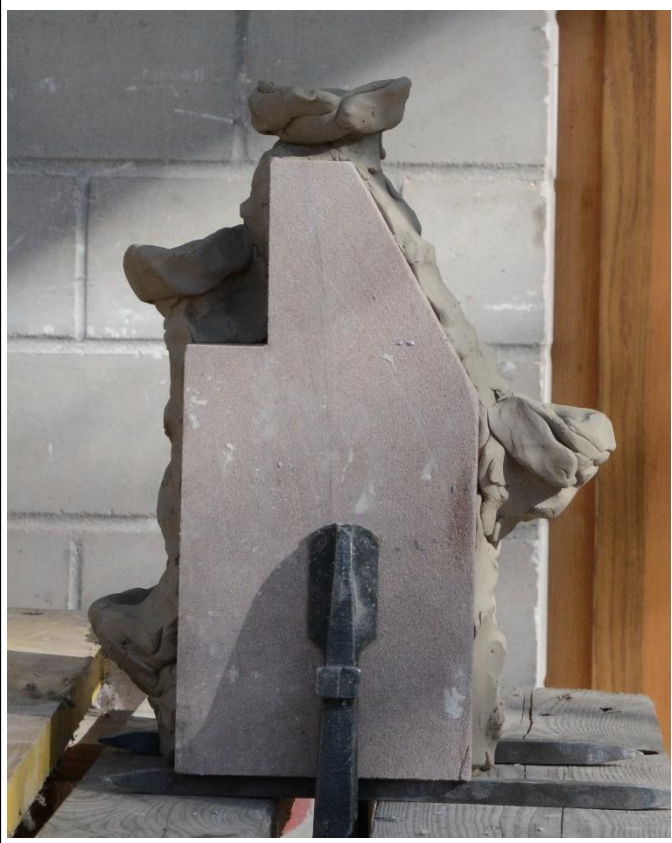
vergießende Fuge mit aus Ton geformten Gussnestern
