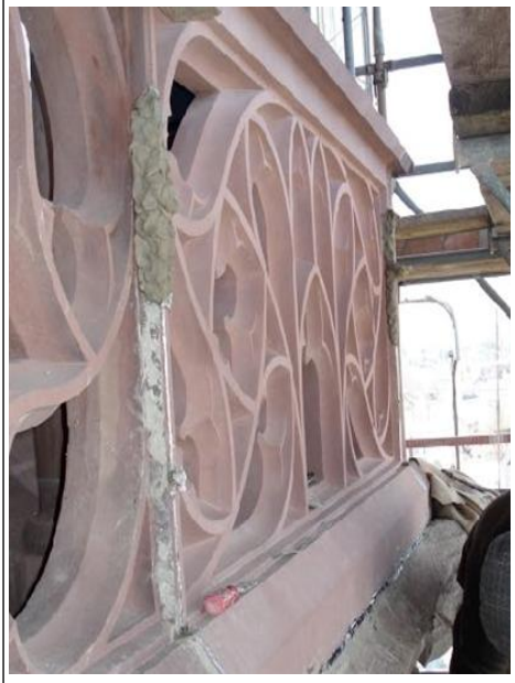
Teil einer Maßwerkbrüstung mit zum Verguss vorbereiteter Senkrechtfuge
