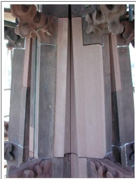
Vierungsstücke an einem Riesen des Martinsturms mit Vierungsstücken vor dem Fugenverguss
